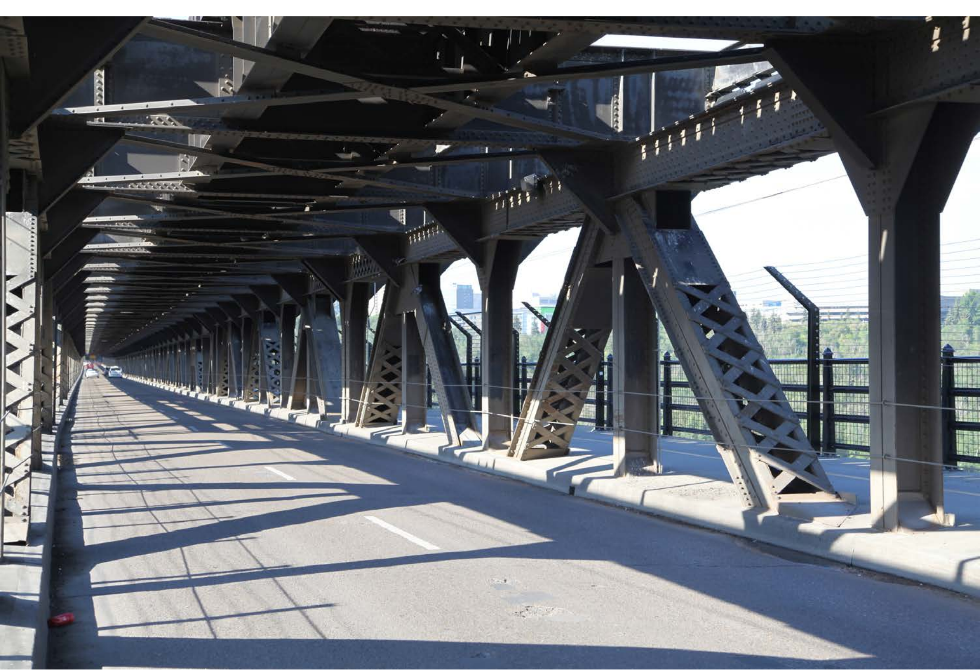
阿尔伯特省埃德蒙顿高桥 (High Level Bridge, Edmonton, Alberta)
